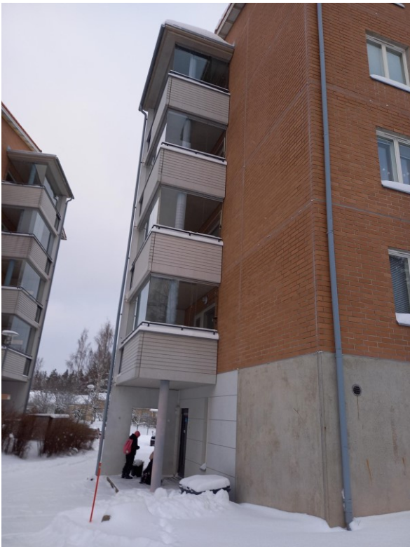
Kuva 2. Vasen pääty (etupihalta katsottuna)
